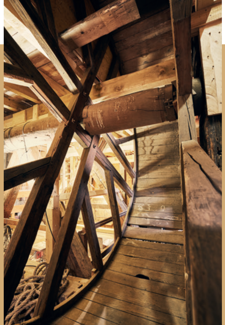
Blick in das Lauftrad; Freiburger Münsterbauverein, Bildarchiv, Foto: Axel Killian
